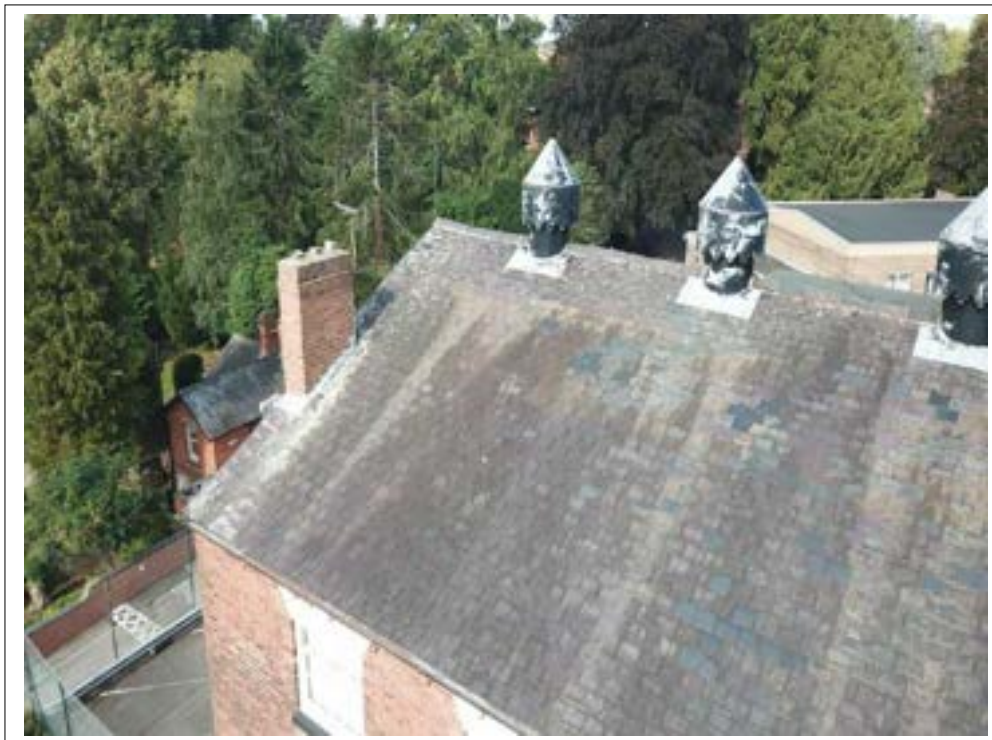
23. Redundant flues
